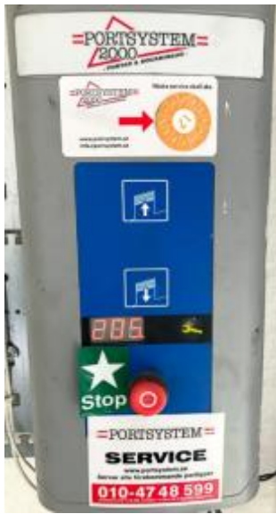
Bild 1: Elektronikbox för garageporten med displayfönster och pilknappar.
