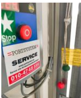
Bild 3: Rep med kulor för fri- respektive inkoppling av portmekanismen
